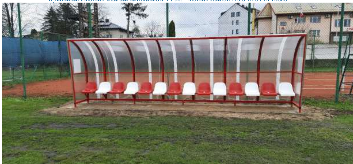
Wykonanie i montaż wiat dla zawodników 14 os. - montaż stadion KS SANOVIA Lesko
