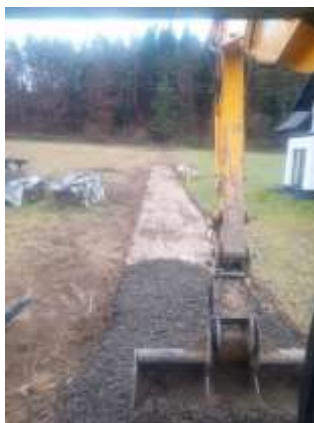
Remont drogi dz. nr ewid. 322 w m. Łączki
