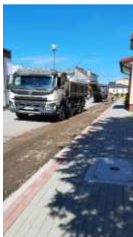
Remont drogi nr 118186R (ul. Parkowa) w Lesku w km 0+005,39-0+142,32
