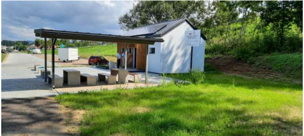
Budowa budynku sanitariatów, wiaty i ścieżki rowerowej w Lesku
