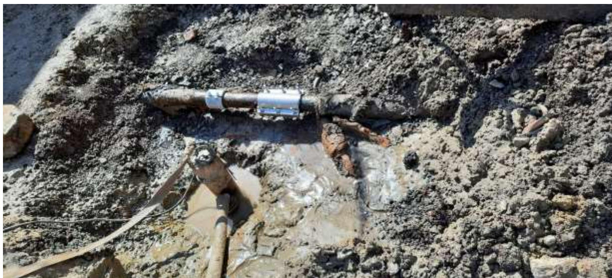
Remont odcinka sieci wodociągowej przy ul. W. Pola w Lesku
