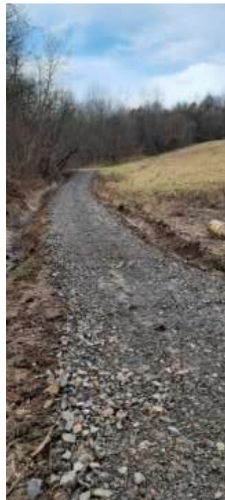
Remont dróg w sołectwie Bezmiechowa Dolna
