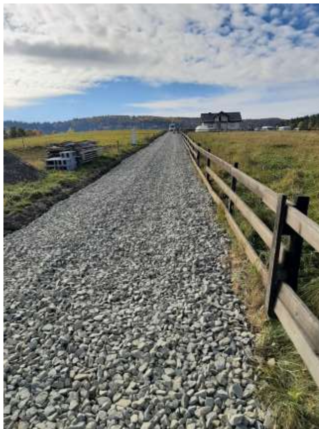
Remont drogi gminnej dz. nr ewid. 54 w m-ci Weremień
