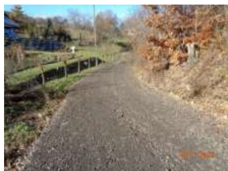
Budowa i modernizacja drogi dojazdowej do gruntów rolnych w obrębie Glinne dz. nr ewid. 309
