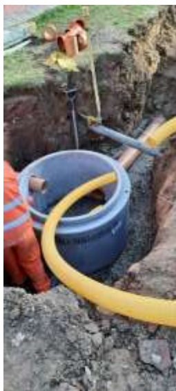
Przebudowa kanalizacji sanitarnej na ul. Broniewskiego w Lesku
