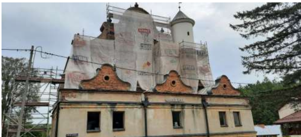
Prace konserwatorskie i roboty budowlane przy elewacji frontowej budynku dawnej synagogi w Lesku
