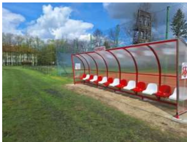
Wykonanie i montaż wiat dla zawodników 14 os. - montaż stadion KS SANOVIA Lesko
