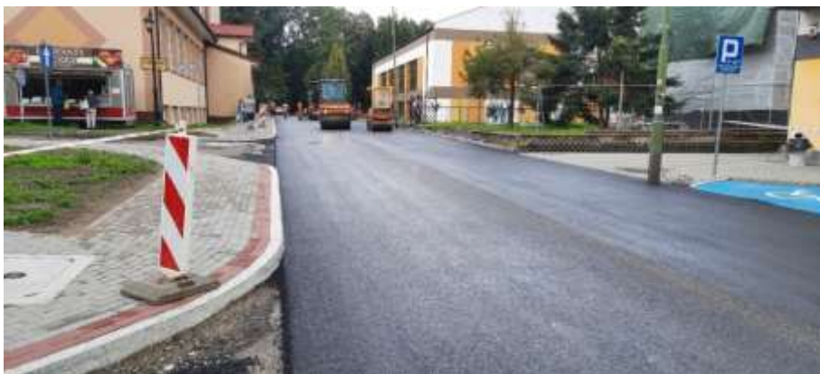
Remont drogi nr 118186R (ul. Parkowa) w Lesku w km 0+005,39-0+142,32
