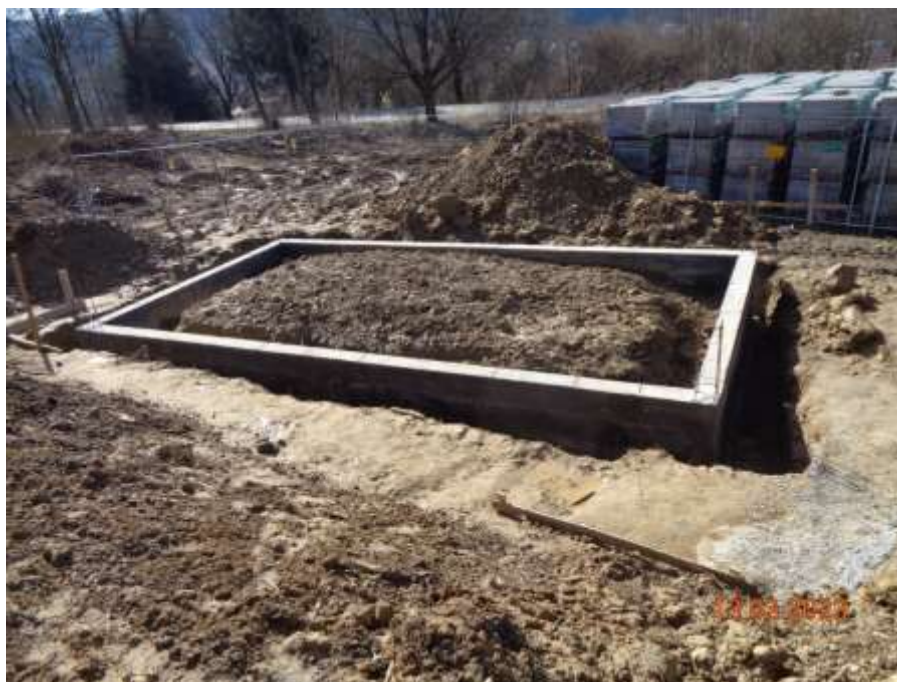
Budowa budynku sanitariatów, wiaty i ścieżki rowerowej w Lesku
