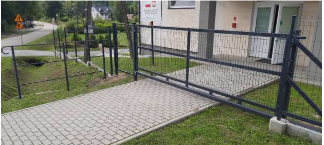
Budowa ogrodzenia wokół świetlicy w Jankowcach poprzez wykonanie bramy przesuwnej systemowej wraz z furtką
