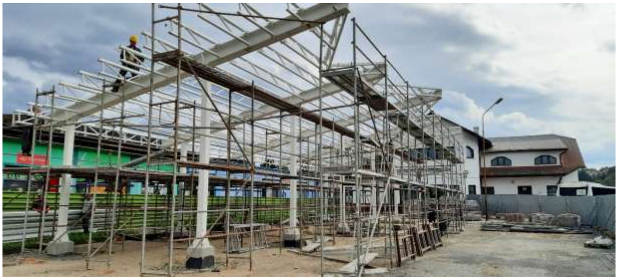
Budowa zadaszenia na dworcu autobusowym w Lesku - etap II
