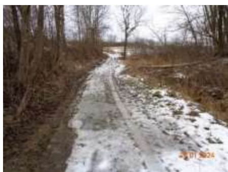
Budowa i modernizacja drogi dojazdowej do gruntów rolnych w obrębie Glinne dz. nr ewid. 309
