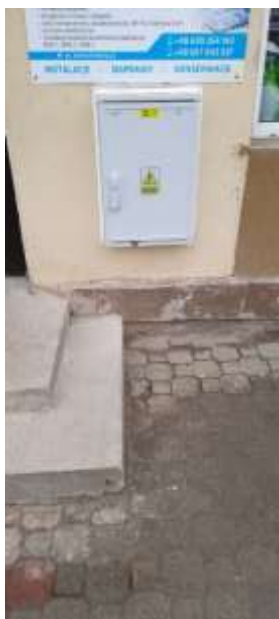
Wykonanie przyłącza do sieci energetycznej - na pl. Pułaskiego/ obsługa imprez kulturalnych
