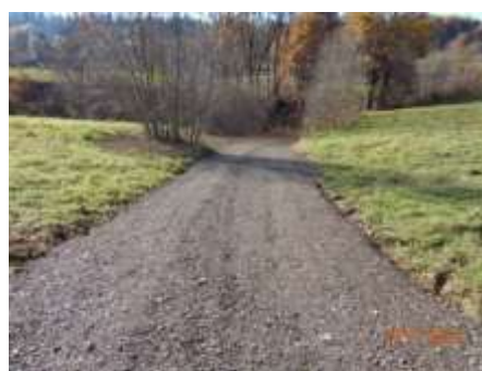
Budowa i modernizacja drogi dojazdowej do gruntów rolnych w obrębie Glinne dz. nr ewid. 309
