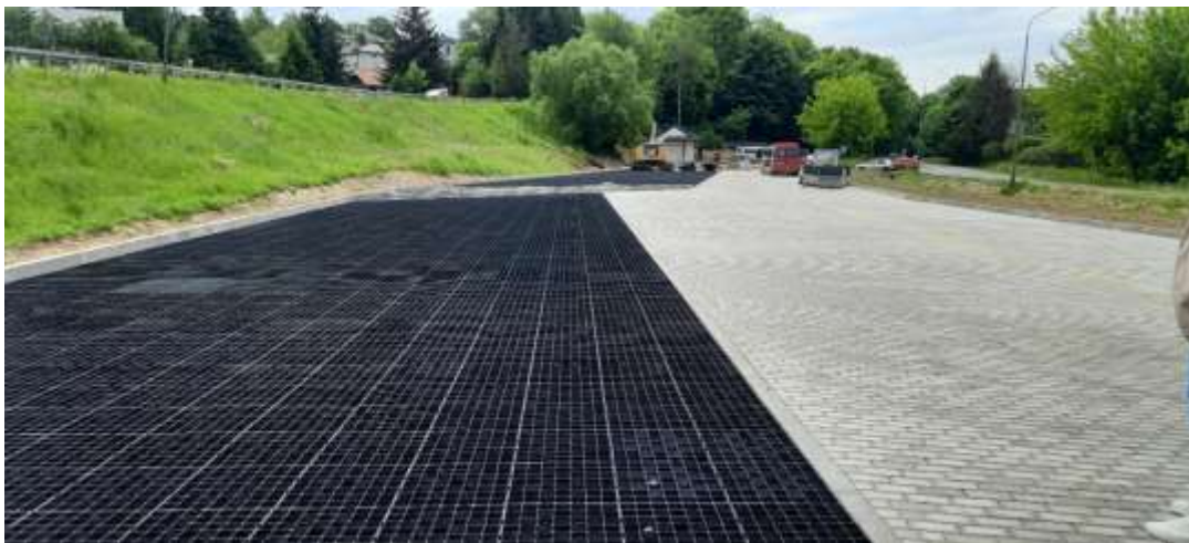
Budowa parkingu ogólnodostępnego, zjazdów publicznych oraz kanalizacji deszczowej w m. Lesko
