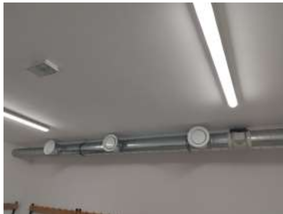
Wykonanie wentylacji mechanicznej w pomieszczeniach podpiwniczenia świetlicy wiejskiej w Jankowcach
