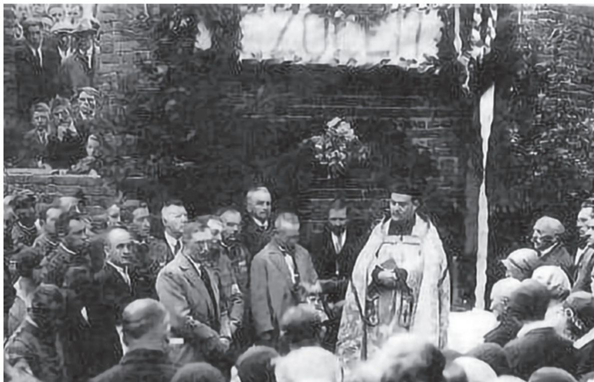
▲ Uroczyste poświęcenie kamienia węgielnego pod budowę nowego gmachu TG „Sokół” w Lesku. Poświęcenia dokonał ks. Mikołaj Orłowski – zdjęcie z książki Józefa Budziaka „Dzieje Leska 1918-1939” str. 60
